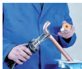
5. Aplicación de la soldadura 5. Aplicação da soldadura
