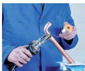
5. Aplicación de la soldadura 5. Aplicação da soldadura
