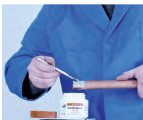
4. Aplicación del decapante 4. Aplicação do decapante
