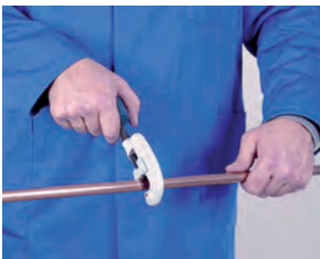
1. Corte de tubo 1. Cortar o tubo
