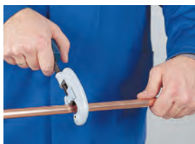
1. Corte de tubo 1. Cortar o tubo
