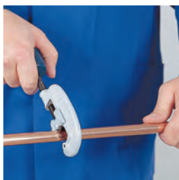
1. Corte de tubo 1. Cortar o tubo
