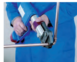
6. Prensado 6. Prensado
