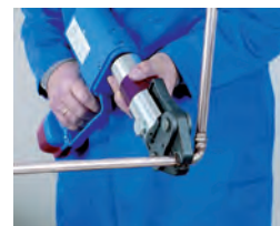
6. Prensado 6. Prensado
