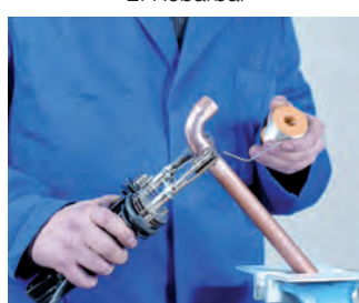
5. Aplicación de la soldadura 5. Aplicação da soldadura
