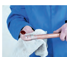
6. Limpieza final 6. Limpeza final
